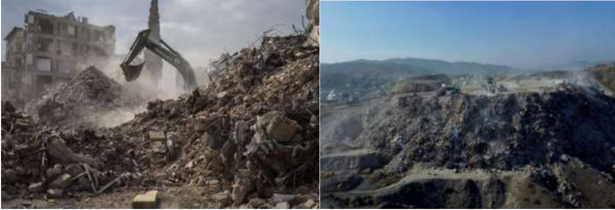
Şekil 1. Depremde yıkılan yapılar ve inşaat atıkları depolama sahalarından görünüm
